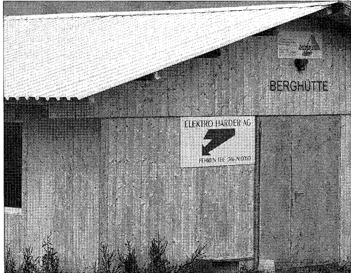
VORBEI Die umstrittene Hütte wird endgültig abgerissen. ARCHIV HDU
