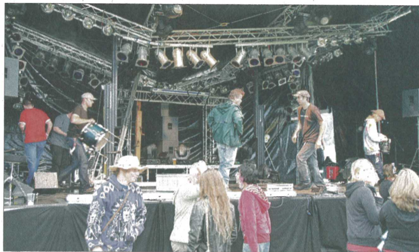
Ratlos: Der grosse Regen vom Samstag drückte die Trägerkonstruktion der Hauptbühne mit den Leuchten herunter. Martin Thomann, Vermieter der Bühne (Bildmitte), organisiert den Abbau.
